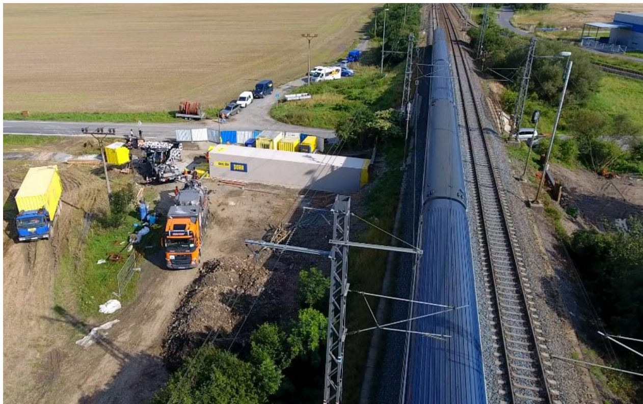
Obr. 5: Unikátní technické řešení - provádění podjezdu pro cyklisty v násypu koridorové železniční trati Olomouc - Česká Třebová
